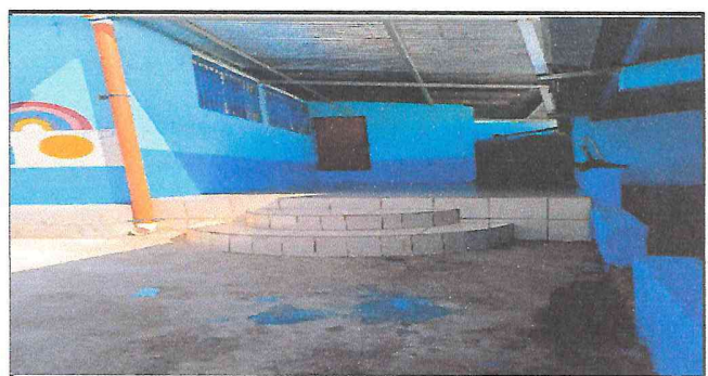
Foto 4: SUSTITUCIÓN DE TORTA DE CONCRETO POR PISO CERAMICO EN ESCENARIO
