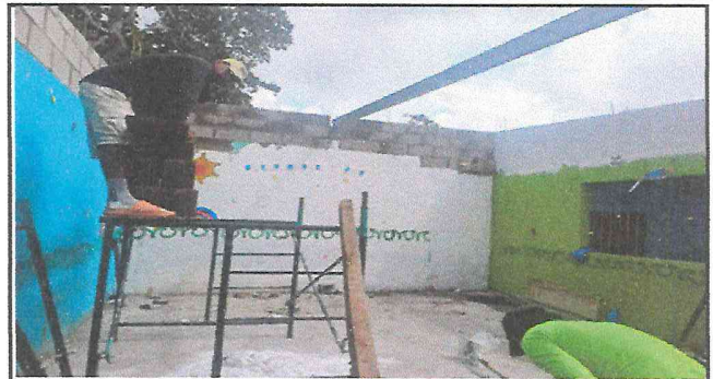
Foto 2: SUSTITUCION DE ESTRUCTURA DE TECHO DE DOS AGUAS POR UNA CAIDA DE AGUA
