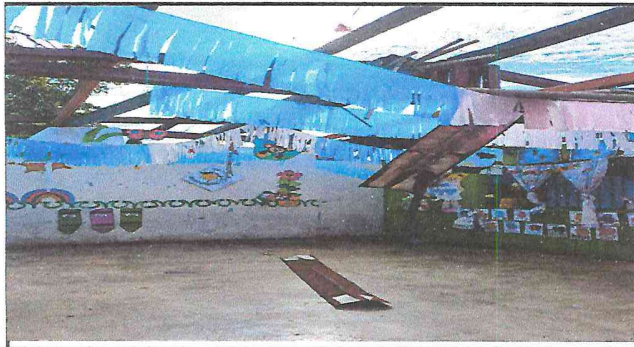
Foto 1: DESMANTELANDO EL TECHO
